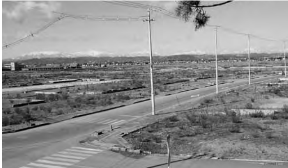
道路と電柱以外の復旧は見られない
