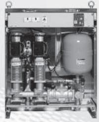
架台のみで基礎とのアンカー位置調整や固定ができるため、施工が楽!
